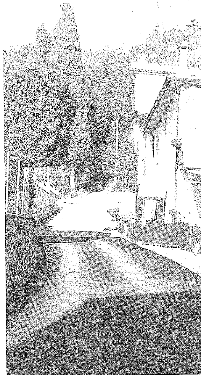
Il manto stradale rifatto in via Fondo dell'Albero
